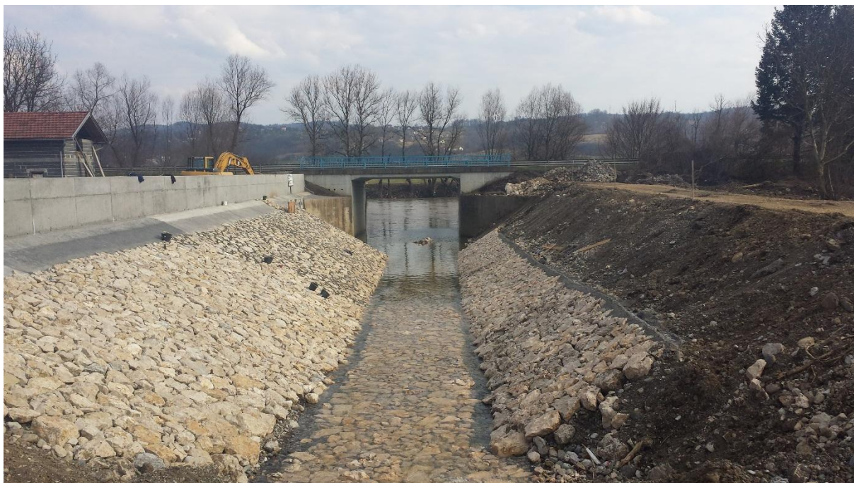
Слика 1. Радови на регулацији ушћа водотока Лијешањ у ријеку Босну
