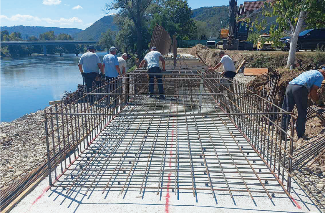
Зворник: Изградња парапетног зида поред ријеке Дрине, за заштиту од поплава насеља Каракај- Терминал
