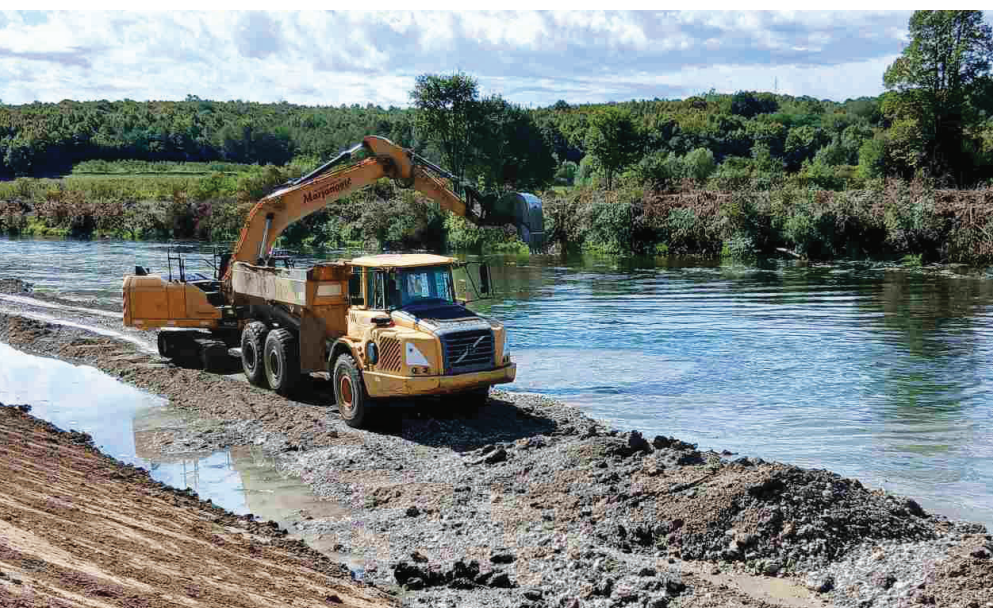
Извођење радова на чишћењу корита ријеке Сане у зони жељезничког моста у Брезичанима
