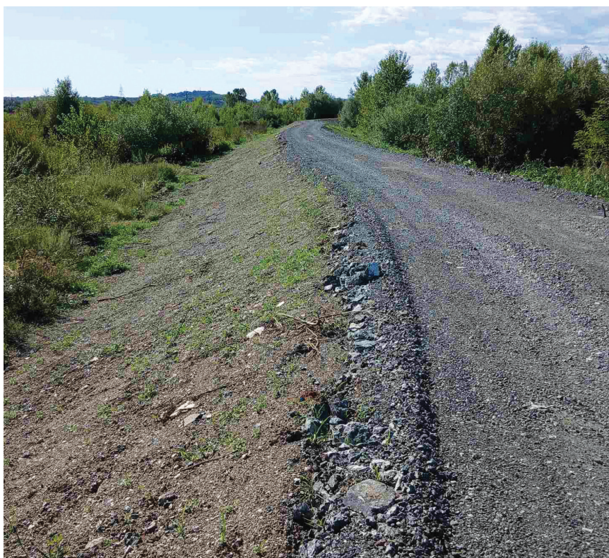
Изглед дионице на којој су изведени радови на издизању терена у јужном дијелу насеља Гомјеница у циљу заштите насеља од поплава
