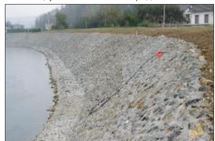
▲ Обалуотврда на ријеци Уни, Нови Град
