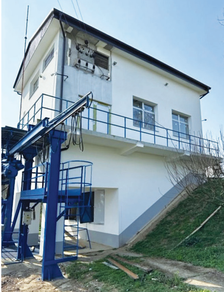
Објекат Црпне станице Топловац 1
