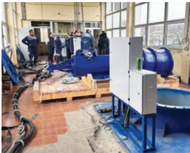
Уградња нових пумпних агрегата
